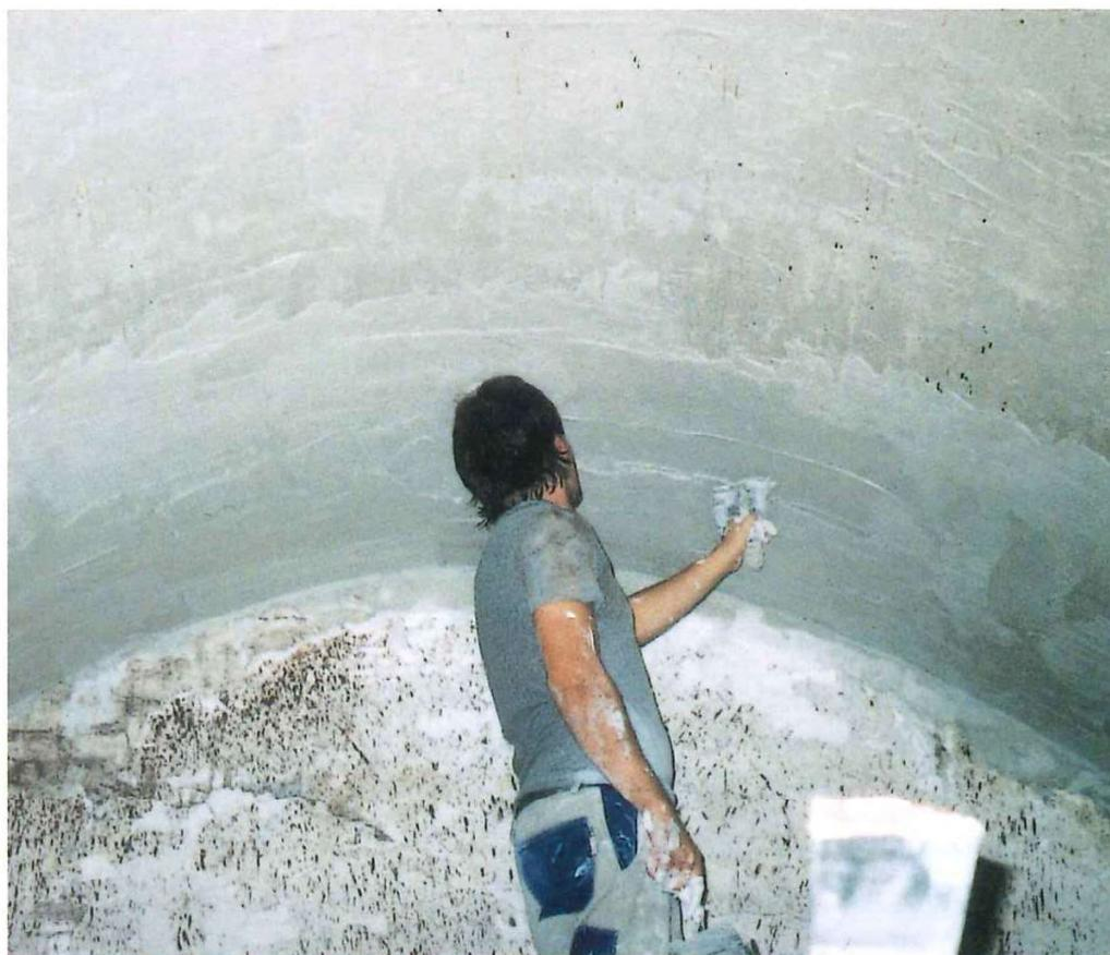
Il lavoro è stato eseguito con tecnologie rispettose di un restauro scientifico escludendo l'impiego di materiali non idonei quali, ad esempio, il cemento.
